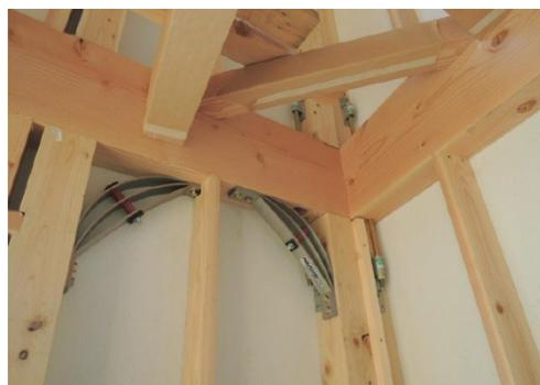
「構造材に負担をかけずに粘り強く揺れに抵抗し、形状を復元する」。そうしたコンセプトのもとに開発された制震装置。地震の水平力をR成形された板ばねで柱軸方向へ受け流し、3枚のばねで吸収、さらに跳ね返りを制御することで減衰効果を高めた。また、円をなすように配置することで円の形状記憶の特性を活用し強さに復元するという。
