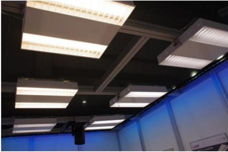
ブース内で体感できるのが、多様な知的照明制御システム。各席ごとに好みの色・明るさに調整できたり、照明によって体感温度を制御したりといった、新丸の内ビルディングや六本木ヒルズ森タワーなどに導入されている最先端のシステムを見ることができる。
